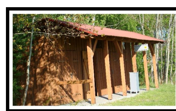
Zaplecze sanitarne na placu wiejskim
